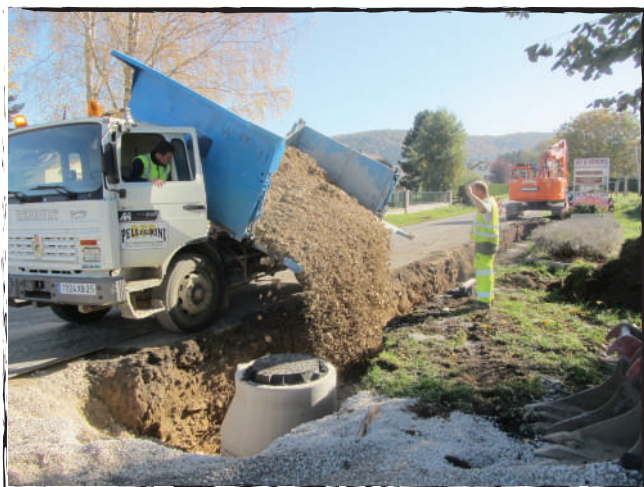
16 octobre 2017 Travaux eau et assainissement
