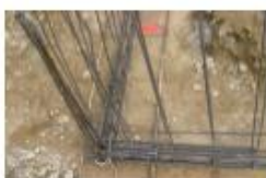
Nœud de chaînage - Continuité mécanique
